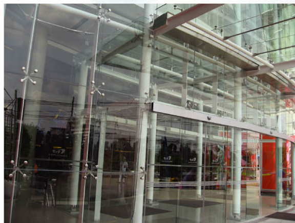
ระบบแขวน อุปกรณ์แขวนรูปตัว-H ระบบแบบยึดถาวร อุปกรณ์แขวนรูปตัว-X
